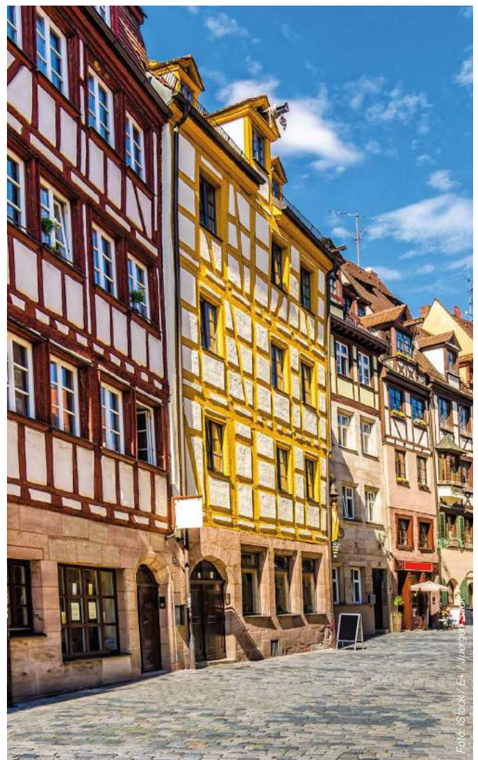
Fachwerkhäuser, eng beieinander – hier sprechen gleich zwei Gründe gegen eine Außen- und für eine Innendämmung
